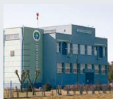
Miejskie Wodociągi i Oczyszczalnia, Grudziądz, Polska
